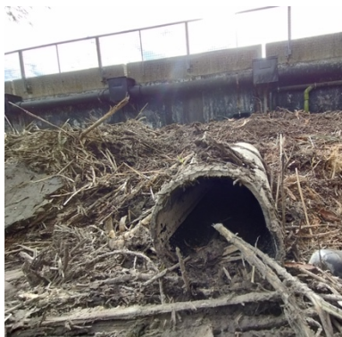
Tuyau trop-plein envasé avant travaux
